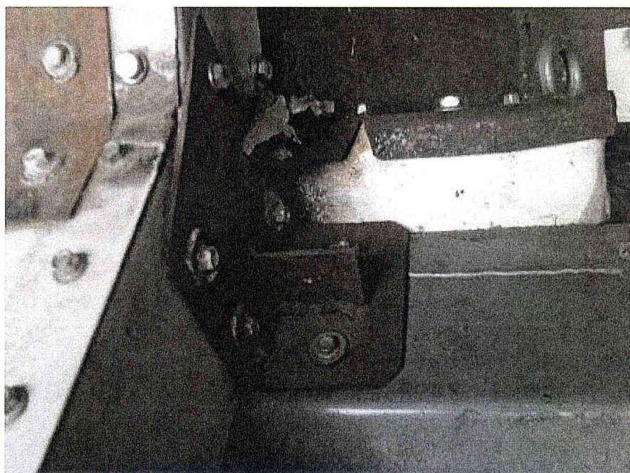
Рисунок 3 – Трещина корпуса стола пневмосортировального после восстановления сваркой с наложением кронштейна.
