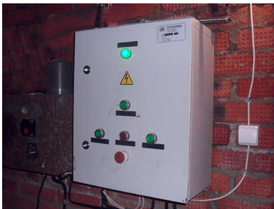
Рисунок 2 – Ящик управления УНС-1.
